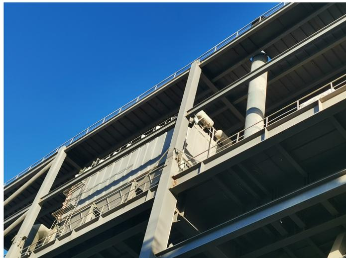
图 3-3 14#二号粉磨线配套除尘系统+排气筒
